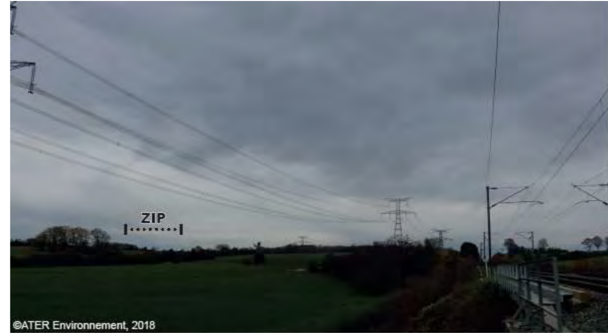
Figure 47 : Axe ferroviaire traversant le territoire d'étude du Nord au Sud pour relier Rethel à Charleville-Mézières (source : ATER ENVIRONNEMENT, 2020)
