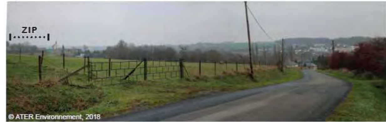
Figure 71 : Vue de l'entrée Nord du village de Rozoy-sur-Serre (source : ATER ENVIRONNEMENT, 2020)
