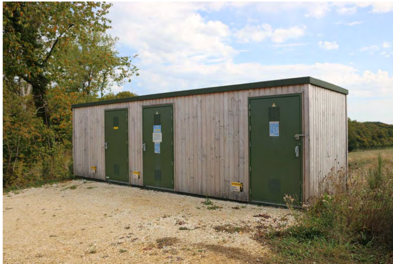
Figure 103 : Photo du type de postes de livraison envisagés (bardage en bois) (source : VENTS DU NORD, 2019)
