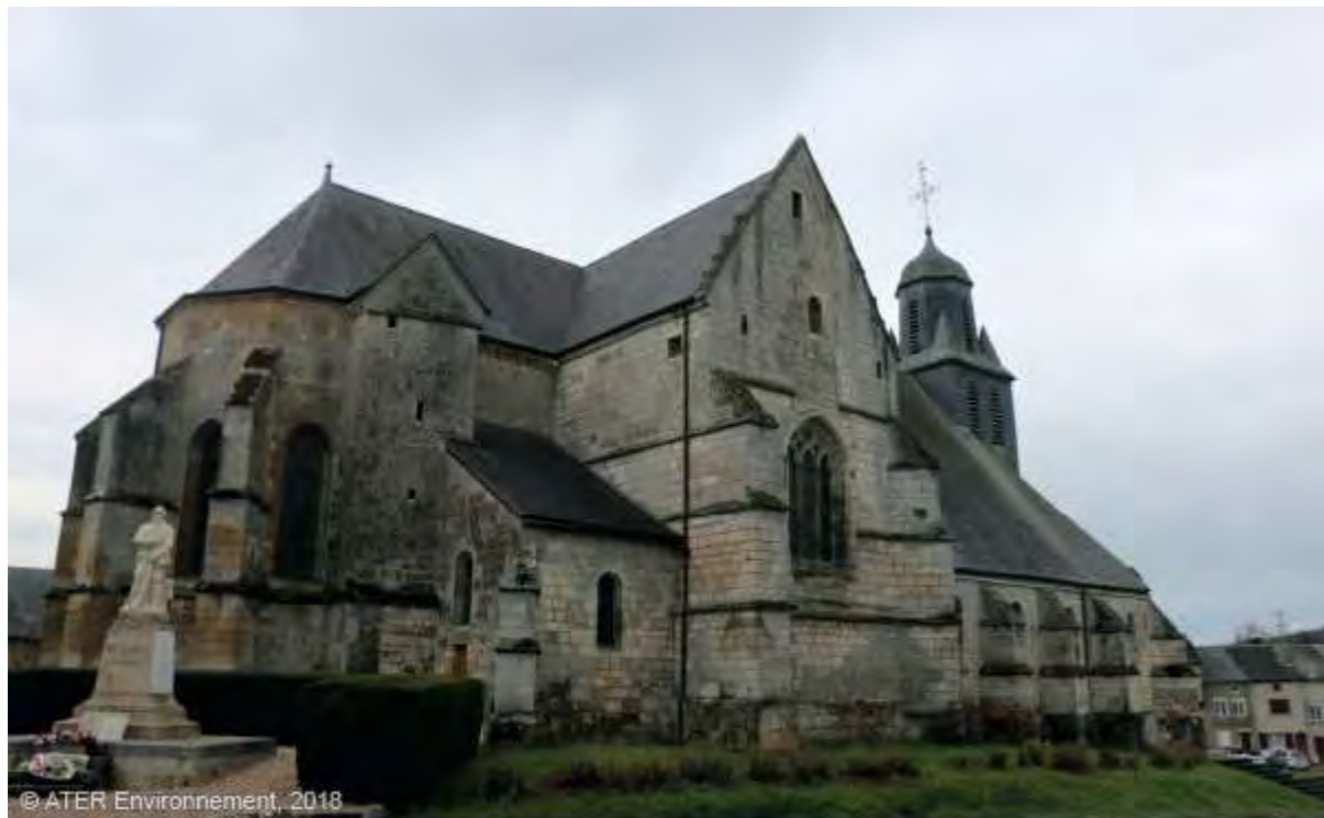
Figure 54 : Eglise fortifiée de Launois-sur-Vence (08) (source : ATER ENVIRONNEMENT, 2020)
