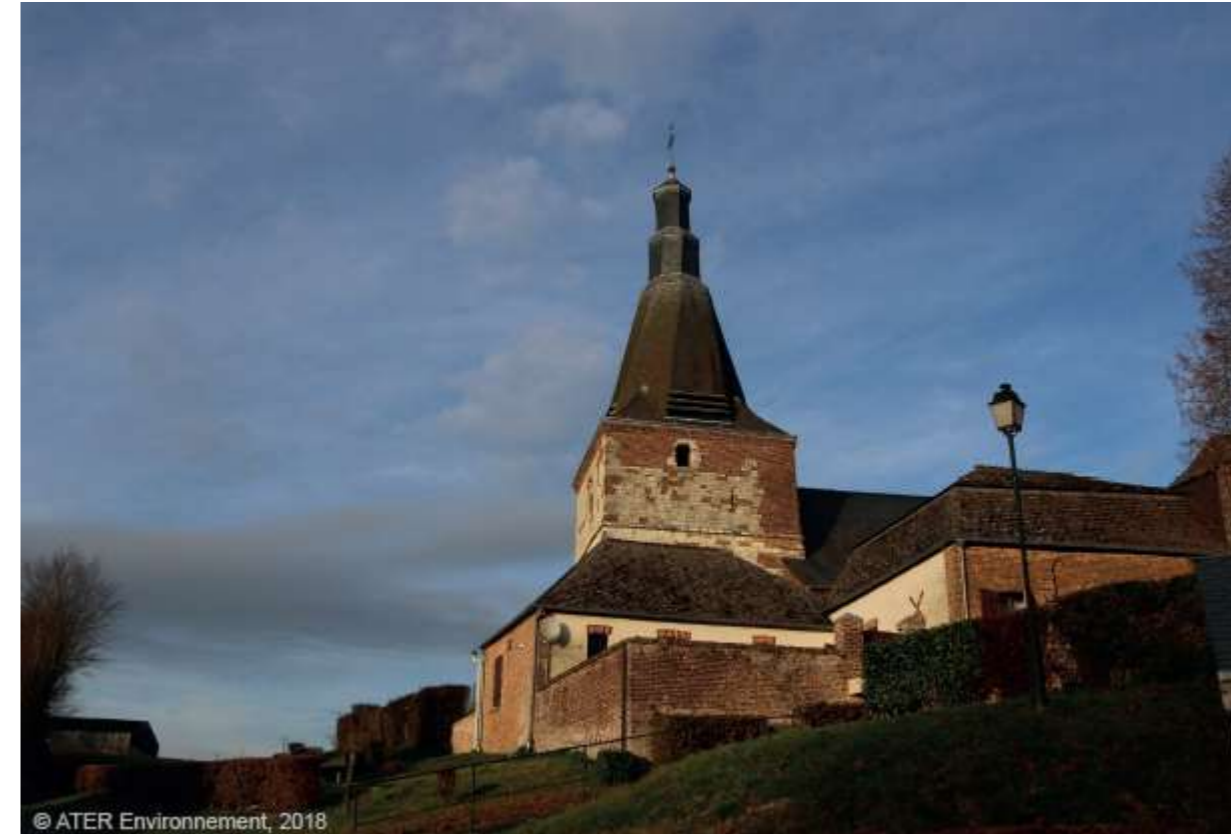
Figure 55 : Eglise fortifiée de Dohis (02) (source : ATER ENVIRONNEMENT, 2020)
