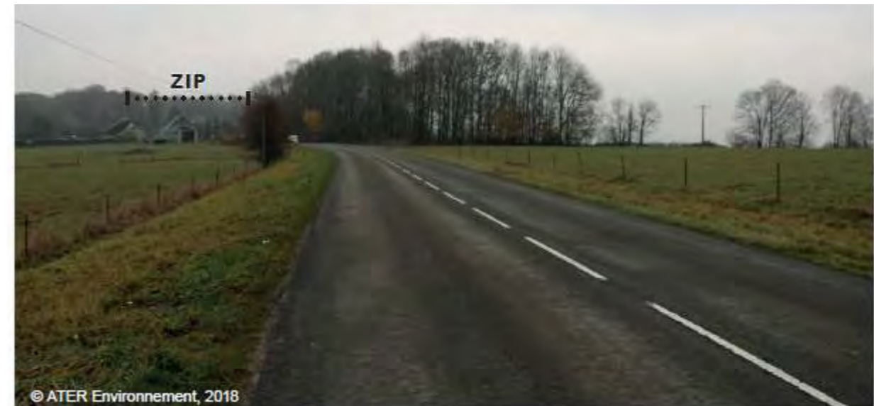
Figure 62 : Vue de la D978 au Nord Est de Mainbressy (source : ATER ENVIRONNEMENT, 2020)
