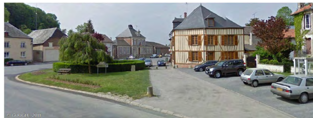
Figure 113 : Vue de la place de l'église de Chaumont-Porcien - avant les travaux d'aménagement paysagers
