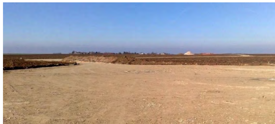
Figure 105 : Exemple d'aire de montage, grave compactée sur géotextile
